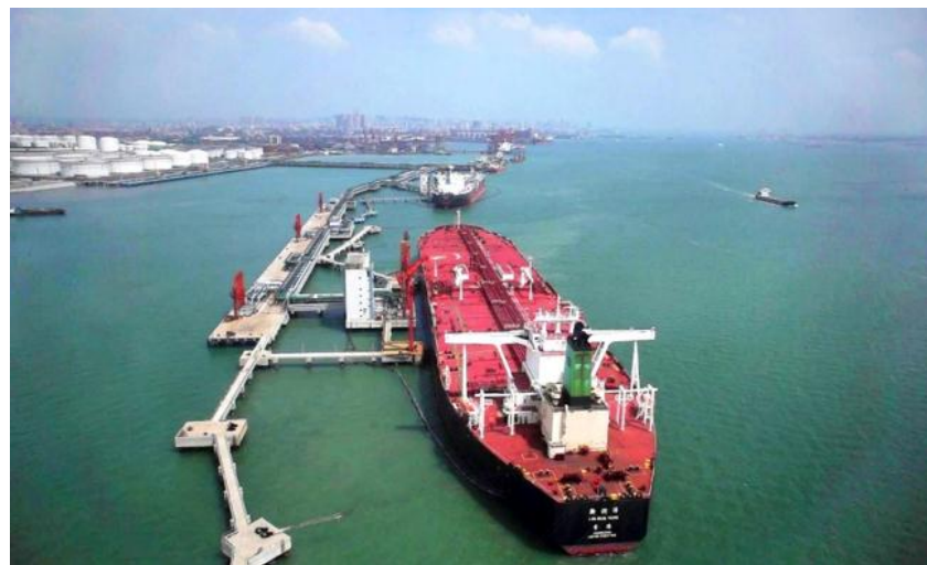
湛江港30万吨级油码头
