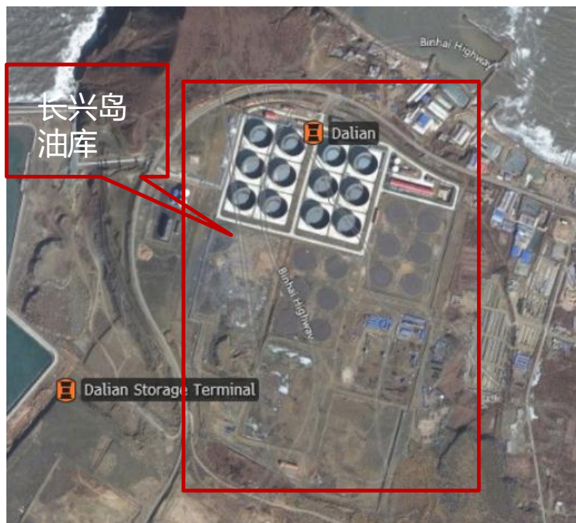
长兴岛原油储罐建设卫星图
