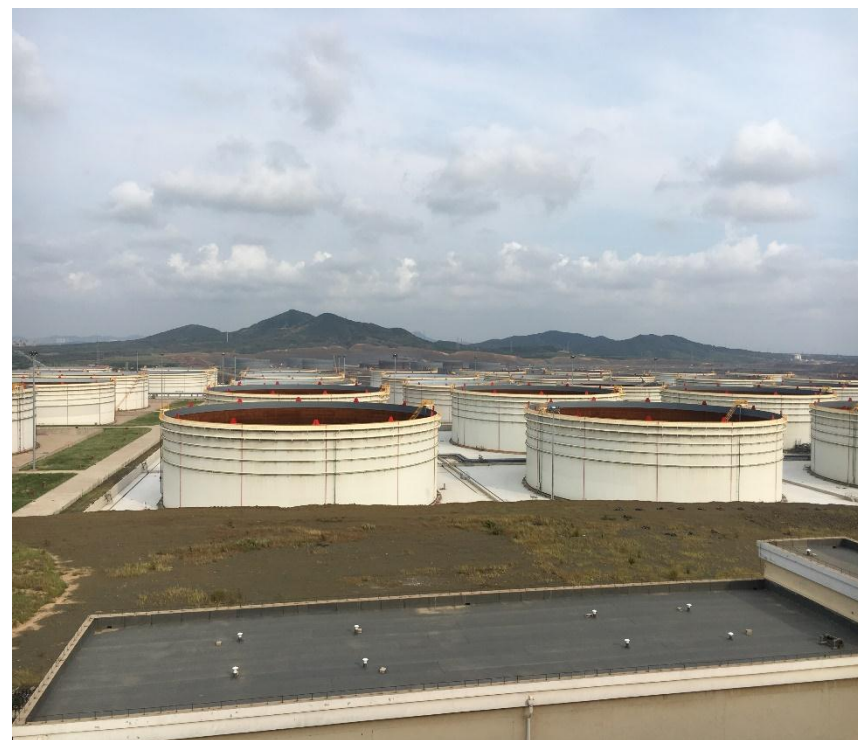
长兴岛目前475万方原油储罐已全部建成
